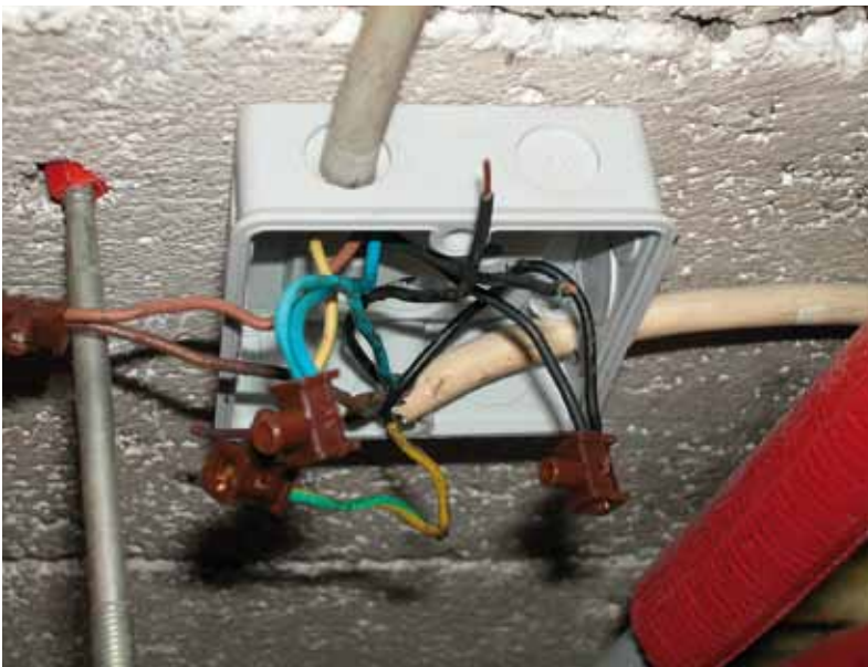
Bild 9: Personengefahr durch offene Abzweigdose im Handbereich
