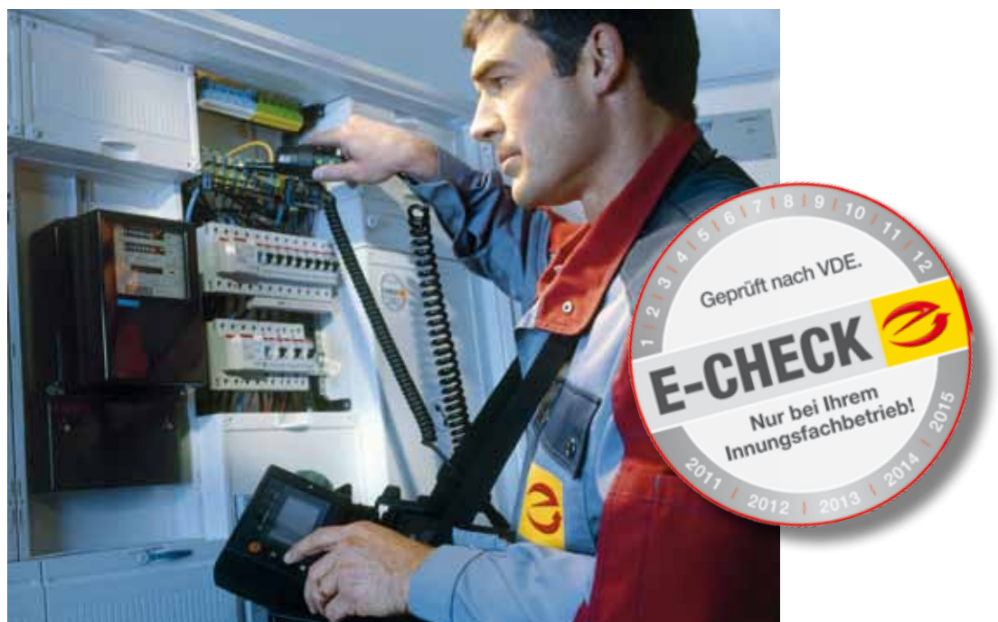
Bild 11: Mit modernen Messgeräten wird eine Anlagenprüfung vom Elektrofachmann durchgeführt.
