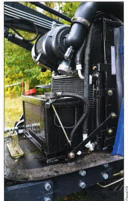
Die Motorhaube öffnet weit. Das Sieb vor dem Kühler ist vorbildlich, das Einfädeln etwas knifflig. Der Motorölstand lässt sich ohne Öffnen der Motorhaube kontrollieren, klasse!
