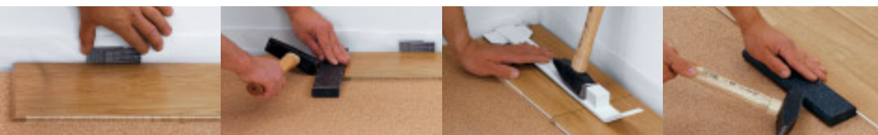
Abb. 20: Schwimmende Verlegung mit leimloser Verbindung
