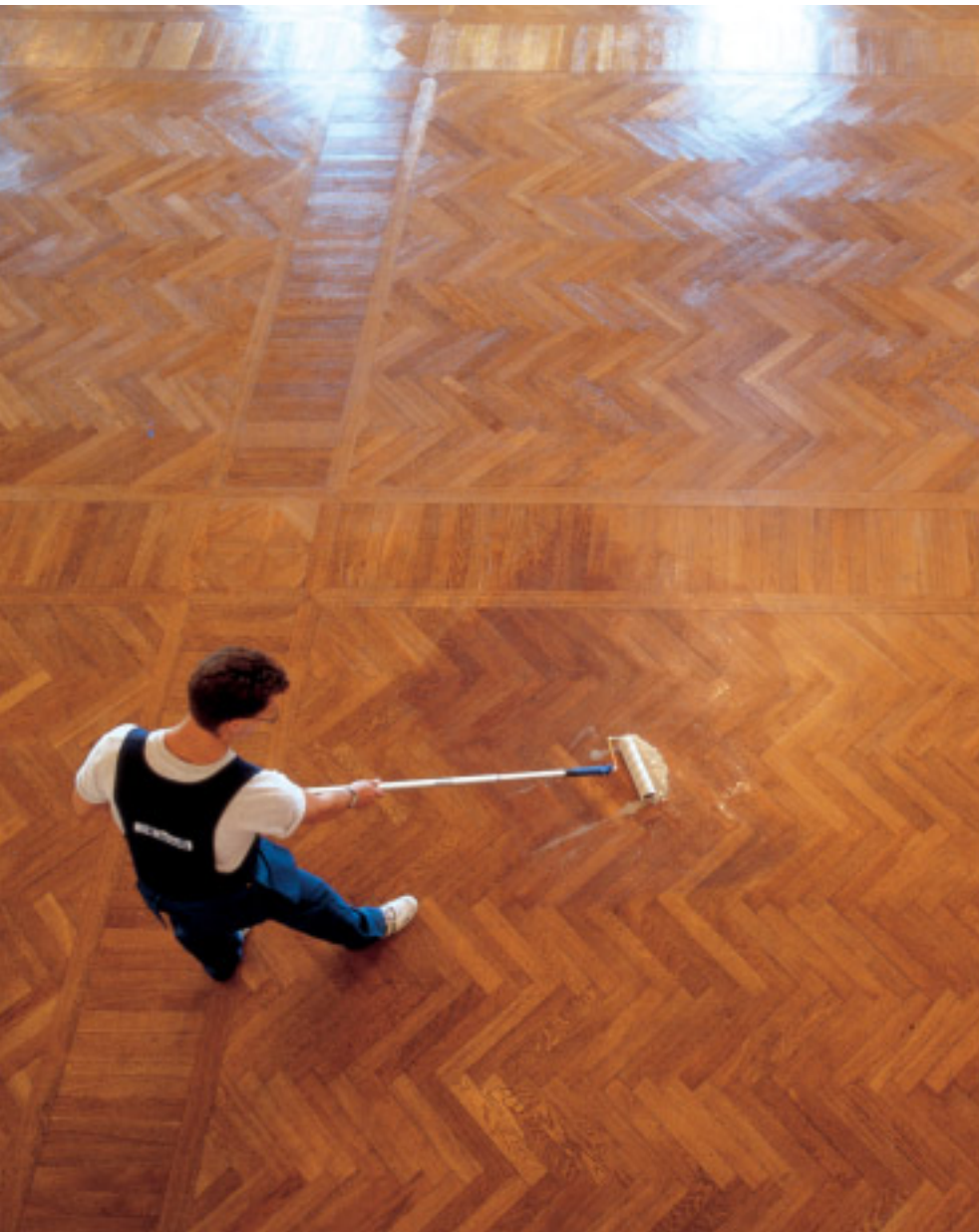
Abb. 24: Handwerkliche Versiegelung des geschliffenen Parkettbodens
