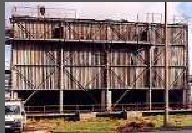
Demontage von Well- und Planasbestplatten Kühlturm Hoechst Trevira Werk Guben.
