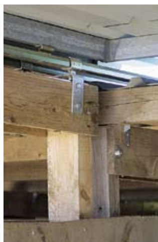
Die Torschienen laufen über die hintere Dachhälfte.
