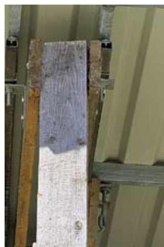
Das Schiebedach wird per Sperrbolzen gesichert.
